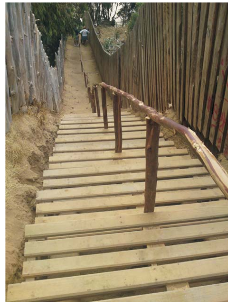
Nuevos escalones y un pasamano, fueron algunos de los arreglos realizados a la escala Cau Cau
